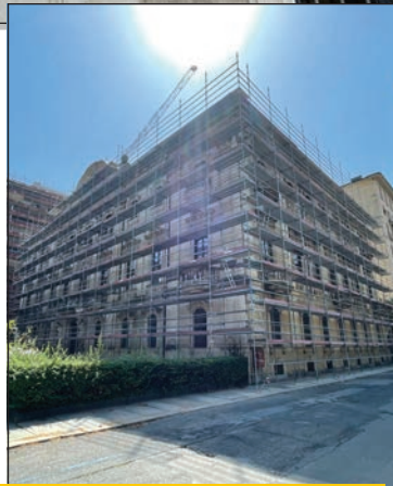
I ponteggi che circondano Palazzo Ceriana Mayneri per la grande opera di restauro e ristrutturazione che comporta anche il rifacimento del tetto
